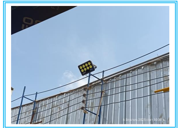
รูปที่ 3-9 ไฟส่องสว่างโดยรอบบริเวณพื้นที่ก่อสร้าง
