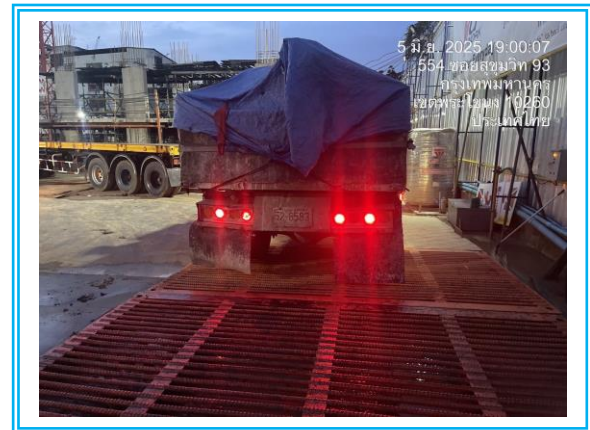
รูปที่ 3-15 รถบรรทุกขนส่งดินต้องปิดคลุมด้วยผ้าใบทึบ
