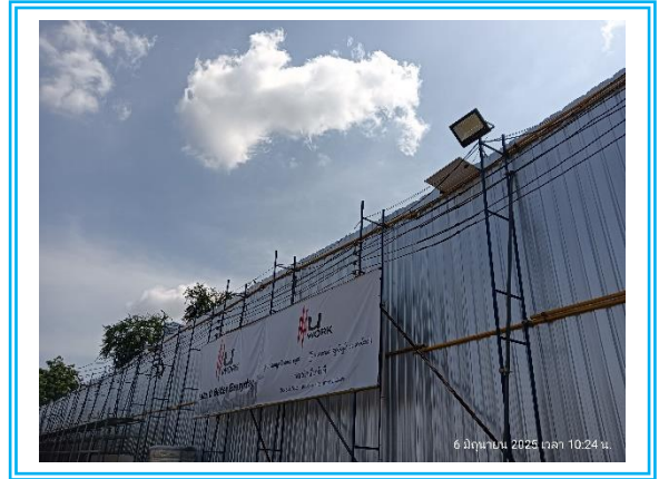
รูปที่ 3-4 รั้ว Metal Sheet สูง 6 เมตร
