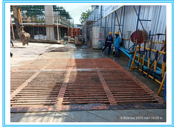
รูปที่ 3-13 พื้นที่สำหรับล้างล้อรถบรรทุก
