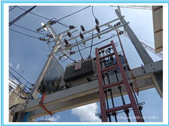
รูปที่ 3-41 หม้อแปลงไฟฟ้า
